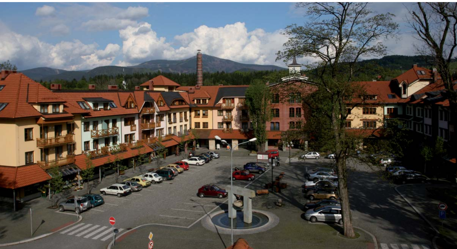
Původní fojtský mlýn vystřídala v 19. století textilní továrna a v padesátých letech 20. století se do uprázdněných budov nastěhovaly sklady vojenského leteckého materiálu. Dnes se na tomto místě nachází centrum obce.
